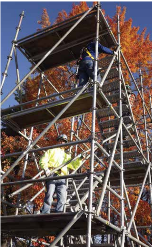
En plus de la démonstration d'échafaudage, il y avait également des présentations de cloison sèche, de portes et de matériel
